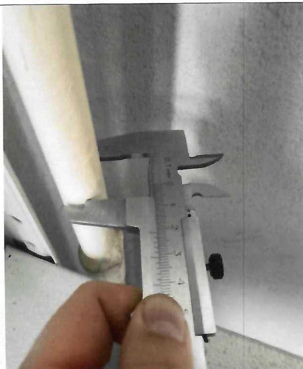
Фото 14. Диаметр тепловой сети на 1-ом этаже
